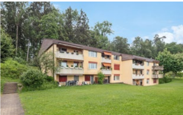
Vue de l'extérieur
