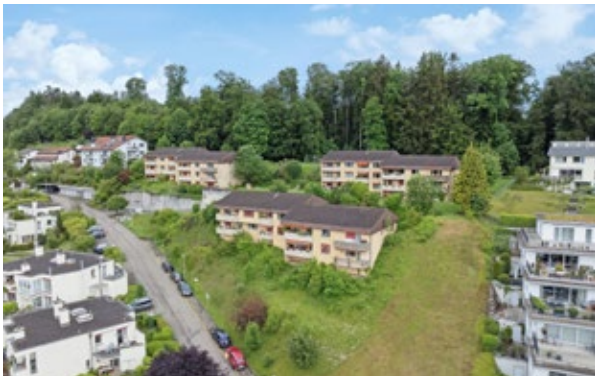
Vue de face, prise par un drone
