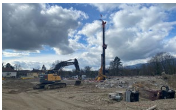
Chantier sur le site Riverside
