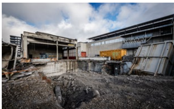
Démolition de la halle 333
