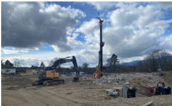
Baustelle auf dem Riverside
