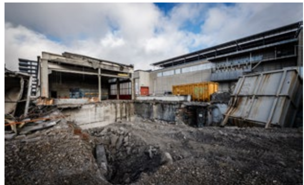
Rückbau der Halle 333
